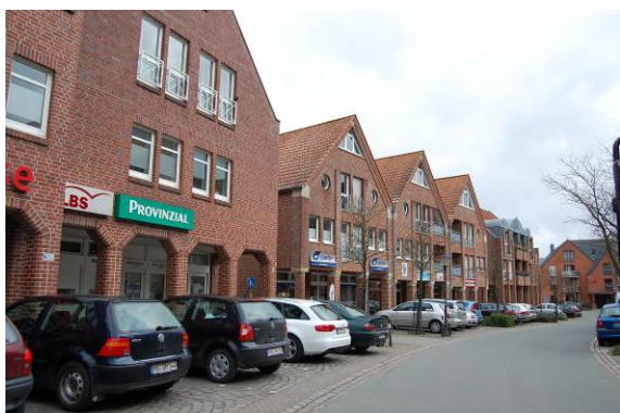
Abbildung 12 Zentrale Stellplätze an der Altenberger Straße
